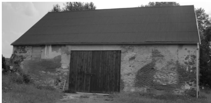
Budova obecní stodoly po rekonstrukci v roce 2010
