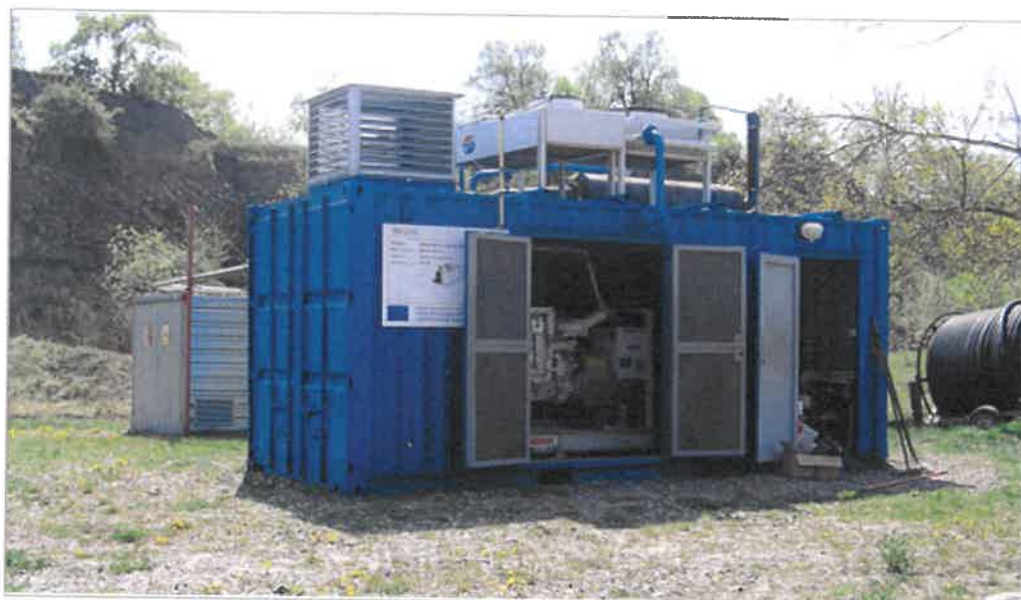
Obr. 1: Kogenerační jednotka
